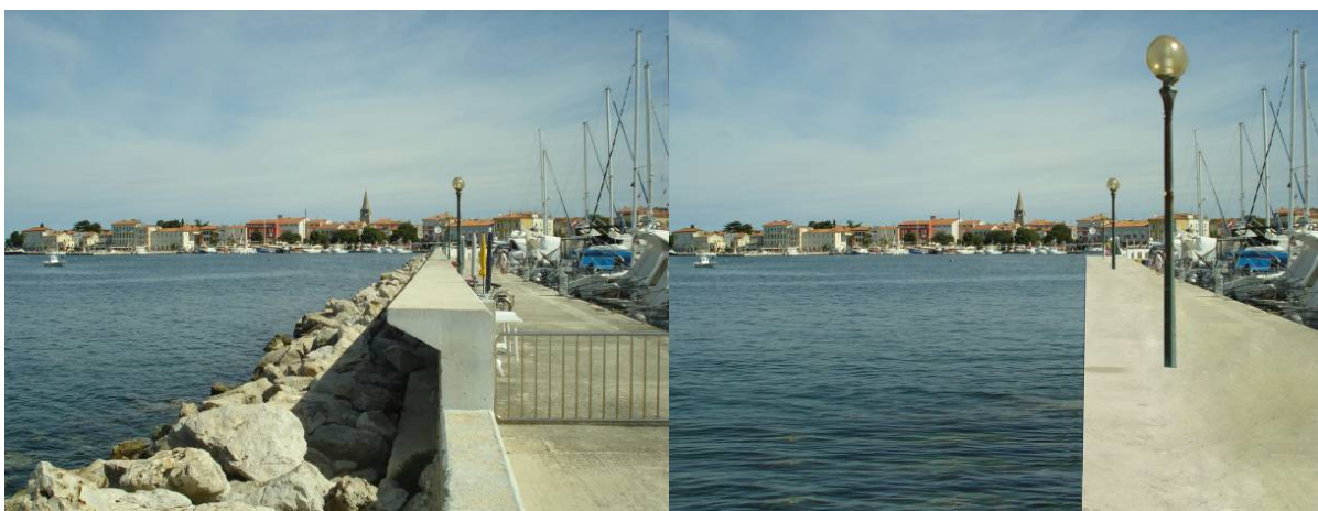
Slika 70. a i b Izgradnja obale za tranzitni vez jahti s vanjske strane lukobrana marine (prije i poslije)
