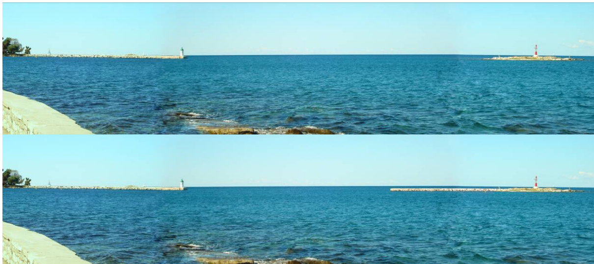
Slika 67. a i b Izgradnja lukobrana na hridi Barbaran (prije i poslije)
