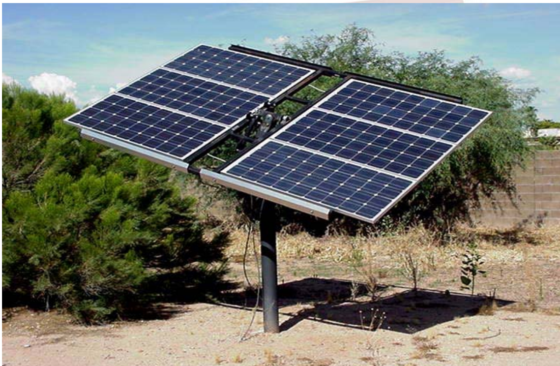
Slika 15 Fotonaponski moduli sa aktivnim praćenjem kretanja suna, Tracker
