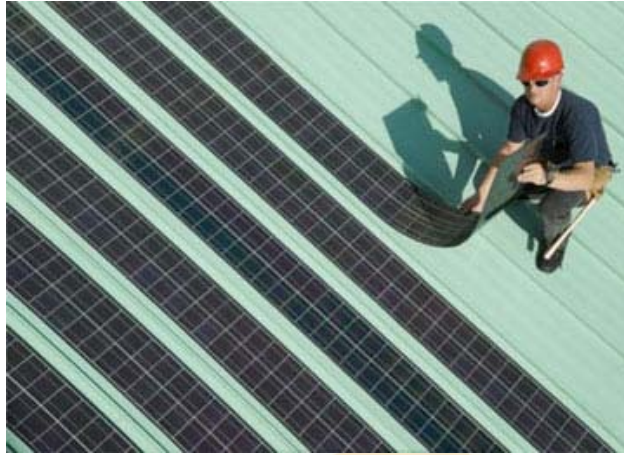
Slika 8 CIS thin-film
