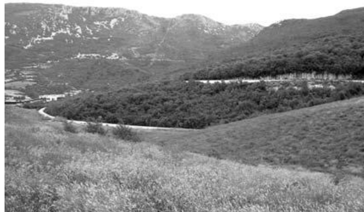
Slika 3 Današnji izgled saniranog odlagališta TE Plomin
