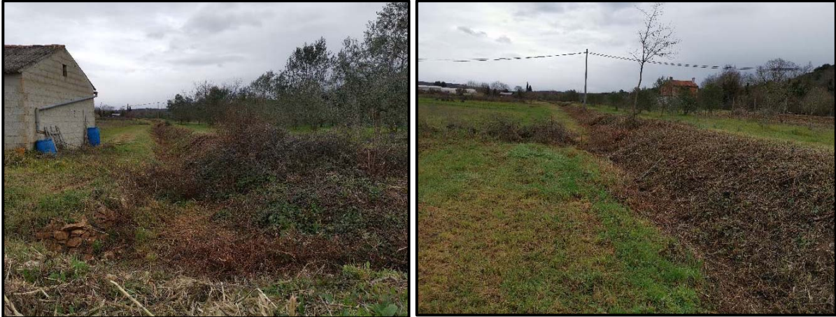
Slika 2.1-8. Vodotok Calchera-Mondelaco, 3. dionica, dionica kanala kroz polje uzvodno od cca stac. km 0+745,00 (izvor: Hidro-expert, 2020.)
