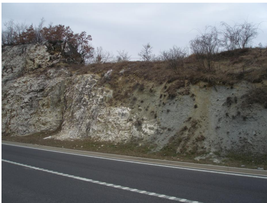
Slika 7. Kontakt karbonatnih stijena i klastičnih naslaga (fliš) na stacionaži 1+700
