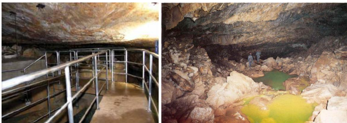
Slika 8. Kaptažni zahvat (lijevo) i kaverna (desno) u tunelu Učka
