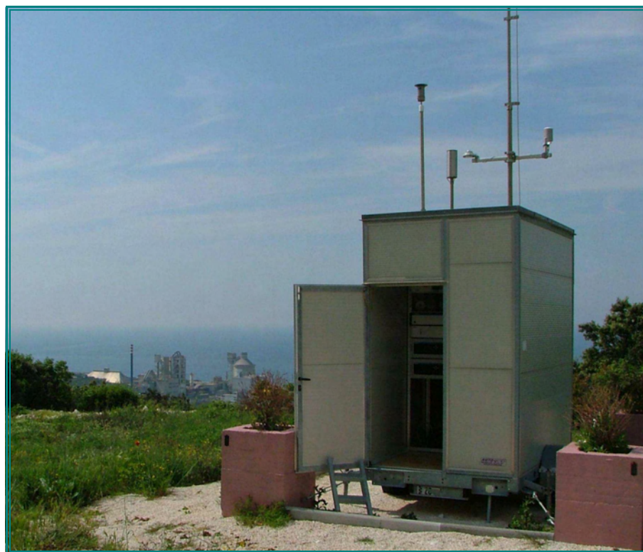
Slika 1c. Automatska mjerna stanica - A.P.Brovinje
