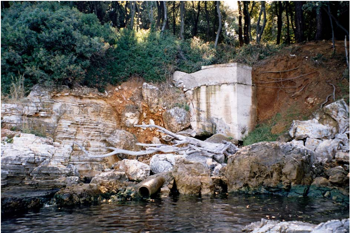
Slika br.13. Šaht iznad odvodnog cjevovoda
