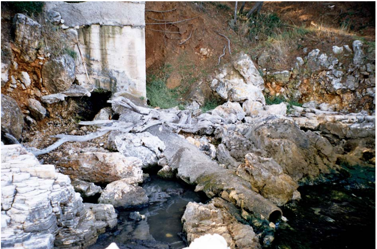
Slika br.13. Šaht iznad odvodnog cjevovoda
