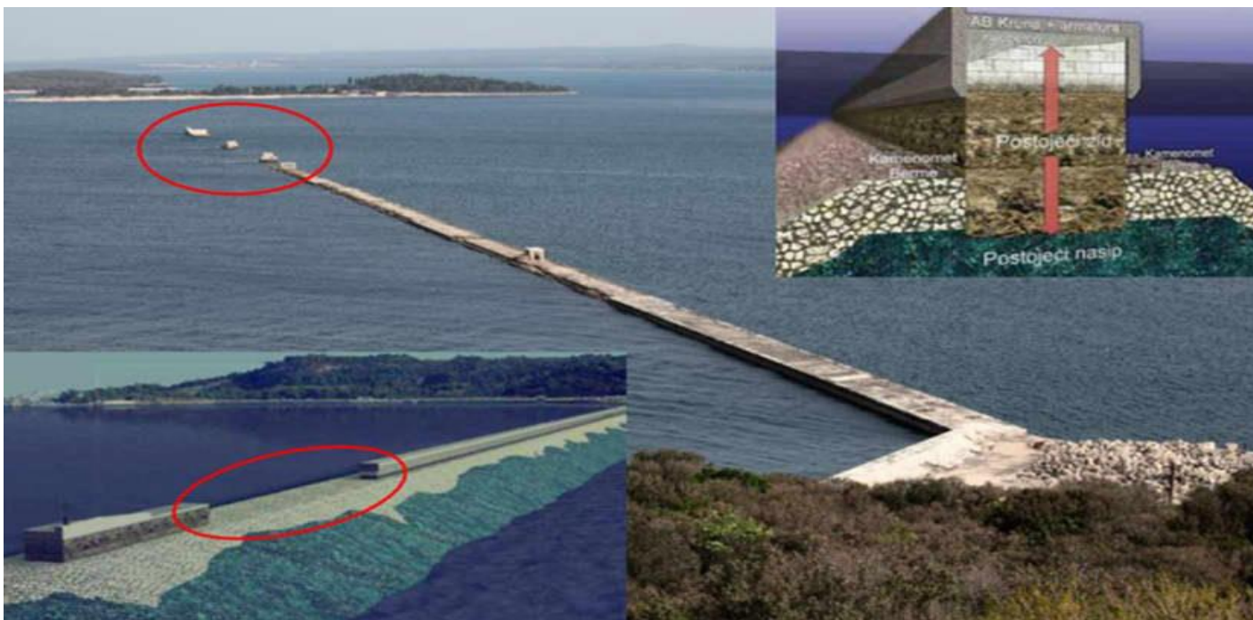
Slika 3: Prikaz lokacije i tehničkih obilježja projekta Rekonstrukcija lukobrana u luci Pula – PULA BREAKWATER
