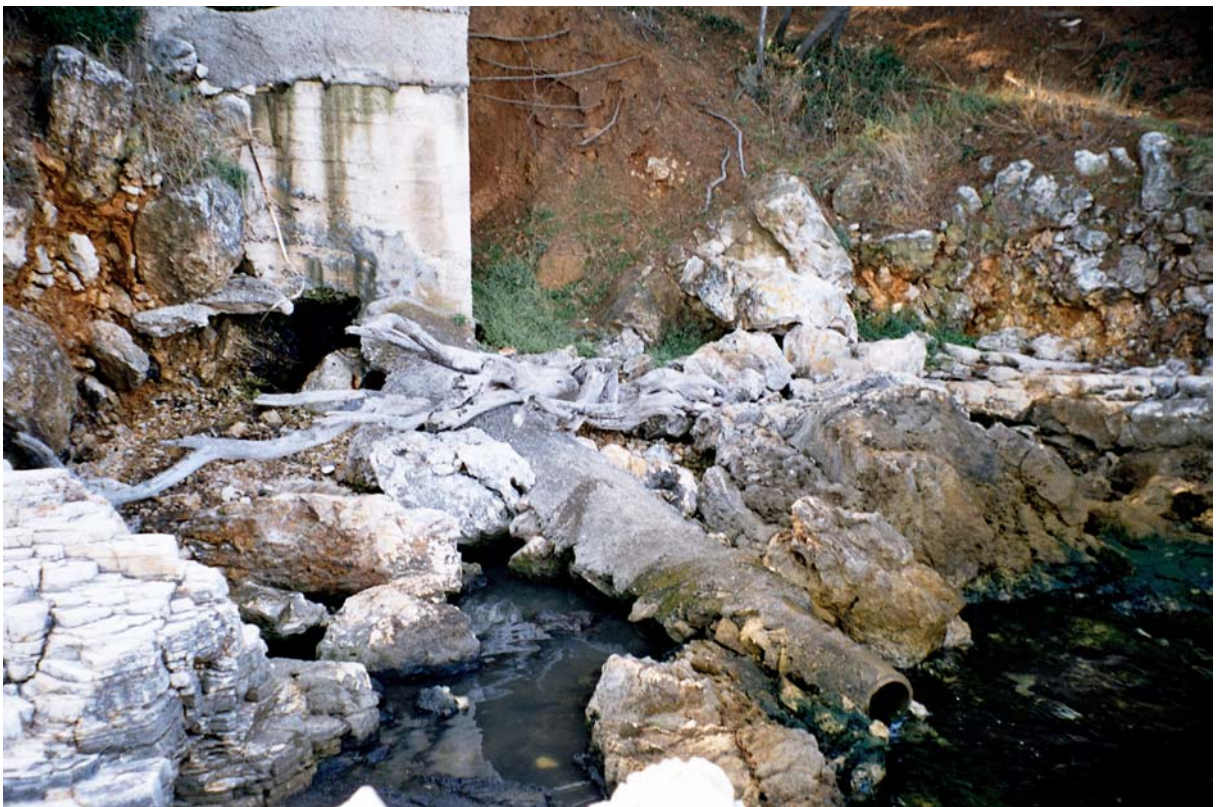
Slika br.13. Šaht iznad odvodnog cjevovoda
