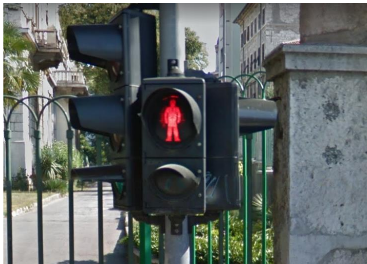
Slika 72.. Semaforska lanterna sa zastarjelim halogenim izvorom svjetlosti
