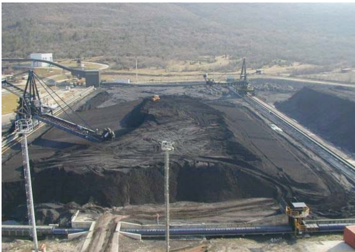
Sl. 4.3-5: Pogled na odlagalište/skladište ugljena s kotla TE Plomin 2; u prvom planu transporter T6; lijevo: kombinirani stroj odlagač/uzimač kapaciteta 1 200 t/h / 500 t/h uzima ugljen s većeg polja odlagališta; u pozadini desno: stari odlagač/uzimač kapaciteta 350 t/h / 350 t/h i manje polje odlagališta; u pozadini lijevo: presipni toranj PT3 s cijevnim transporterom
