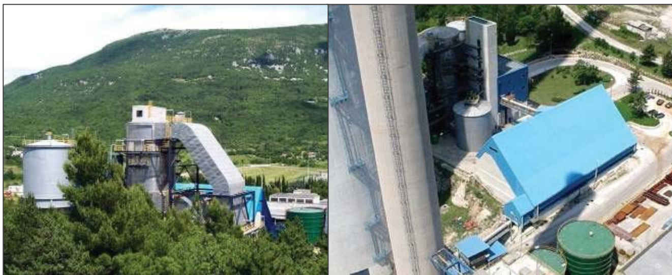
Slika. 4.5-2: Postojeće postrojenje za odsumporavanje i skladište gipsa u TE Plomin
