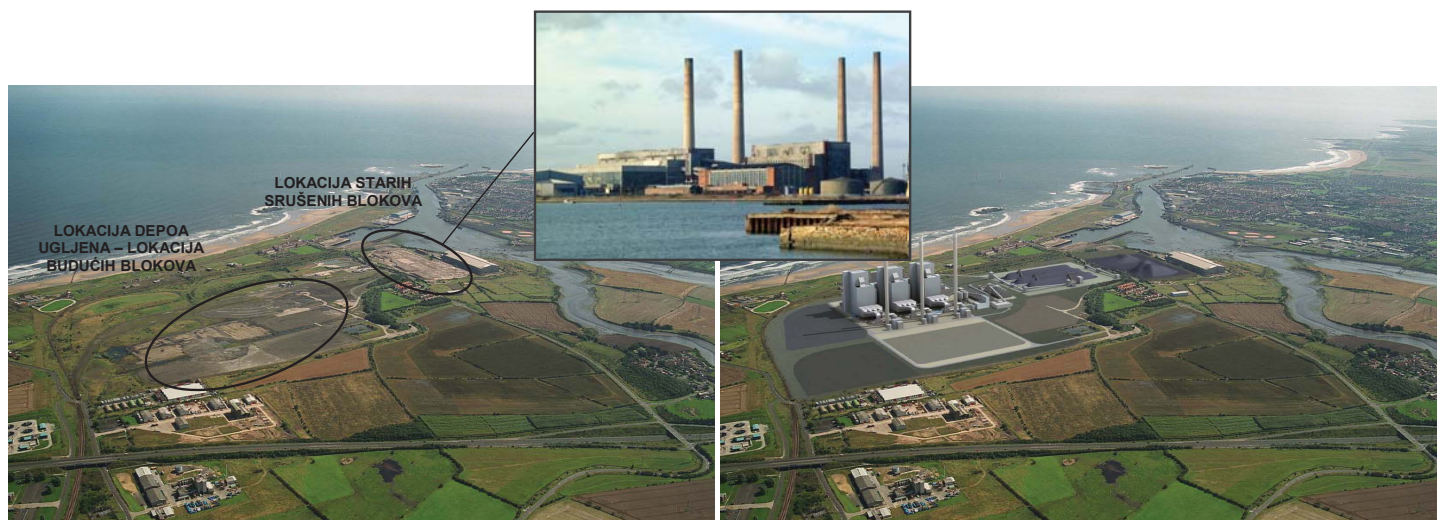
Slika 4.7-8: Još jedan projekt RWE npower – nova 3 bloka (3 x 800 MW) termoelektrane na ugljen na lokaciji postojećih blokova Blyth A (480 MW) i B (1250 MW) koji su srušeni krajem 2003. godine. U planu je izgradnja «capture ready» elektrane. Projekt je trenutno odgođen. ( http://www.journallive.co.uk/north-east-news/todays-news/2009/11/10/blyth-power-station-plans-put-on-back-burner-61634-25129375/ )
