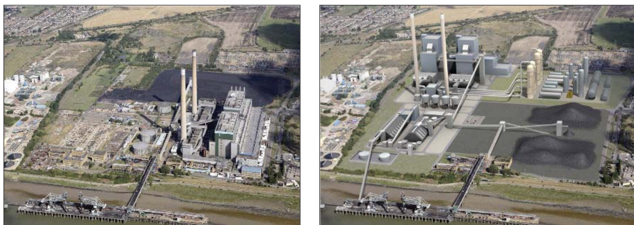
Slika 4.7-7: Postojeća Tilbury termoelektrana (lijevo) i buduća Tilbury termoelektrana (2x800 MW) sa CCS sustavom na mjestu današnjeg depoa ugljena (desno) - projekt RWE npower. Projekt je odgođen nakon što je vlada VB odbila financirati izgradnju CCS sustava na novoj elektrani. ( http://www.thurrockgazette.co.uk/news/4733610_1billion_power_station_plan_shelved/ )
