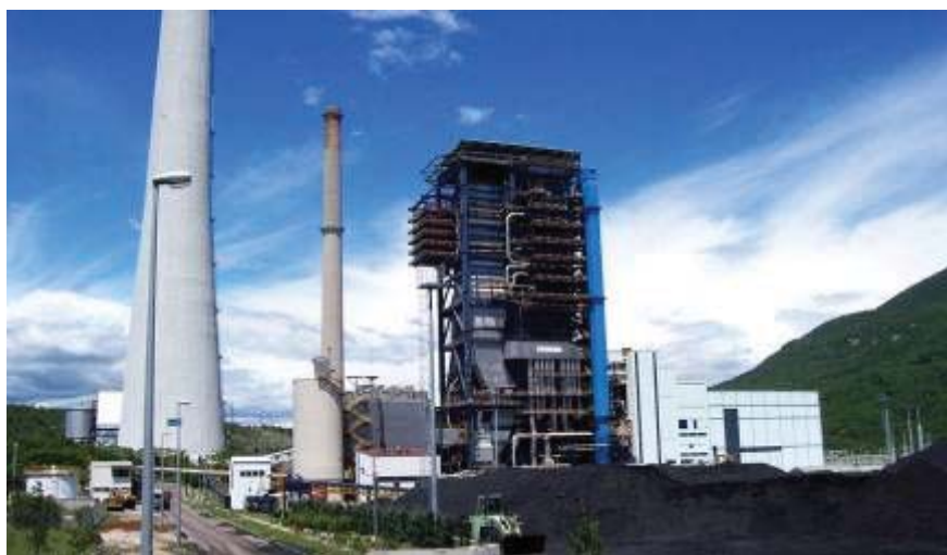
Slika 2.1-2: Postrojenje TE Plomin 2
