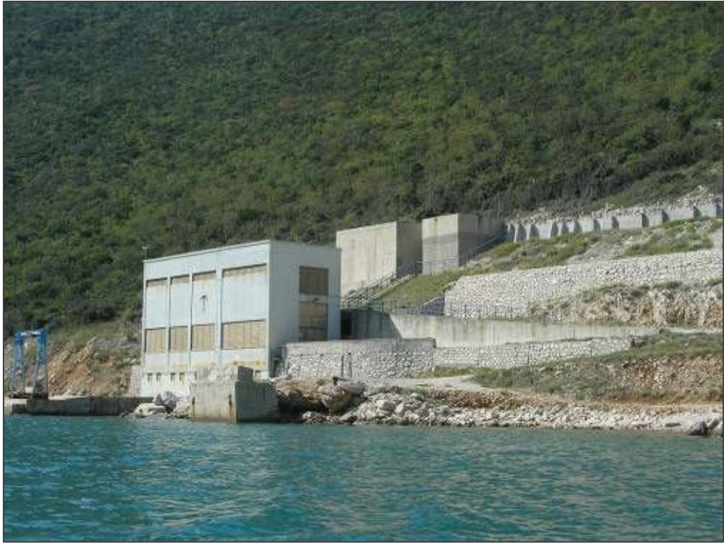
Slika 4.2-3: Usisna građevina s pet pumpi
