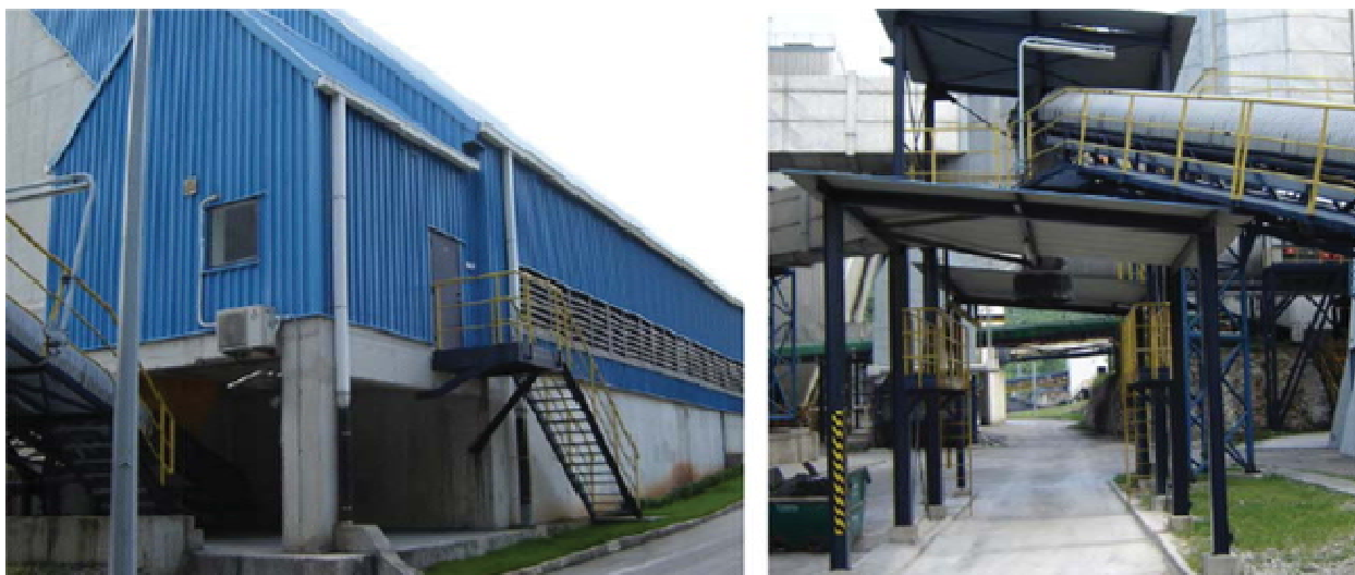
Slika 4.6-1: Spremište gipsa TEP 2 (lijevo) i utovarna rampa za gips (desno)
