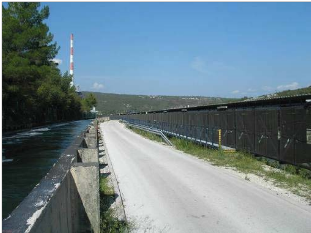
Slika 4.2-4: Otvoreni dovodni kanal
