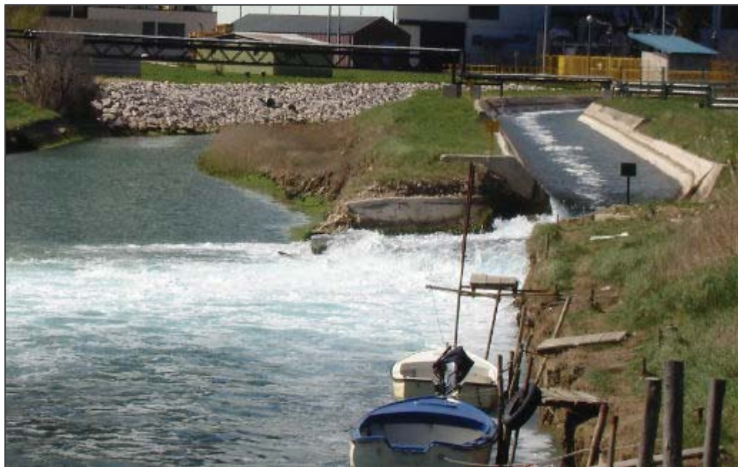
Slika 4.2-5: Ušće otvorenog izljevnog kanala u rijeku Buljunciću
