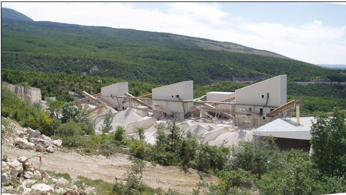
Slika 1.2.-3. Stabilno drobilčno-separacijsko postrojenje za oplemenjivanje otkopane mineralne sirovine
