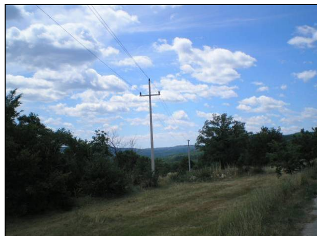
Slika 3.8.-29. Betonski stupovi dalekovoda
