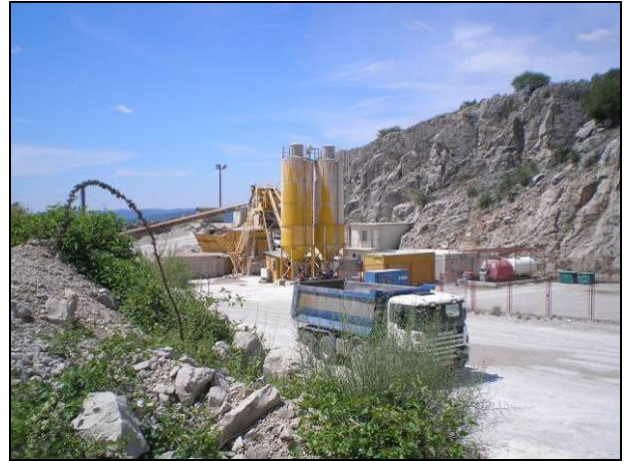
Slika 3.8.-34. Betonara i rudarski objekti u sklopu radnog platoa
