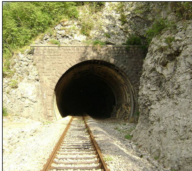
Slika 3.12.-2b. Zapadni ulaz u tunel "Vranja 2"
