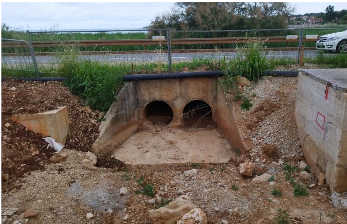
Slika 5. Postojeća glava cestovnih propusta u državnoj magistralnoj cesti DC 75 (izvor: Idejni projekt za ishođenje posebnih uvjeta, Hidro-expert d.o.o., srpanj 2025.)
