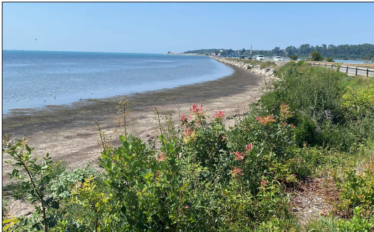
Slika 24. Pogled prema dionici ceste na nasipu uz more (pogled prema zapadu)
