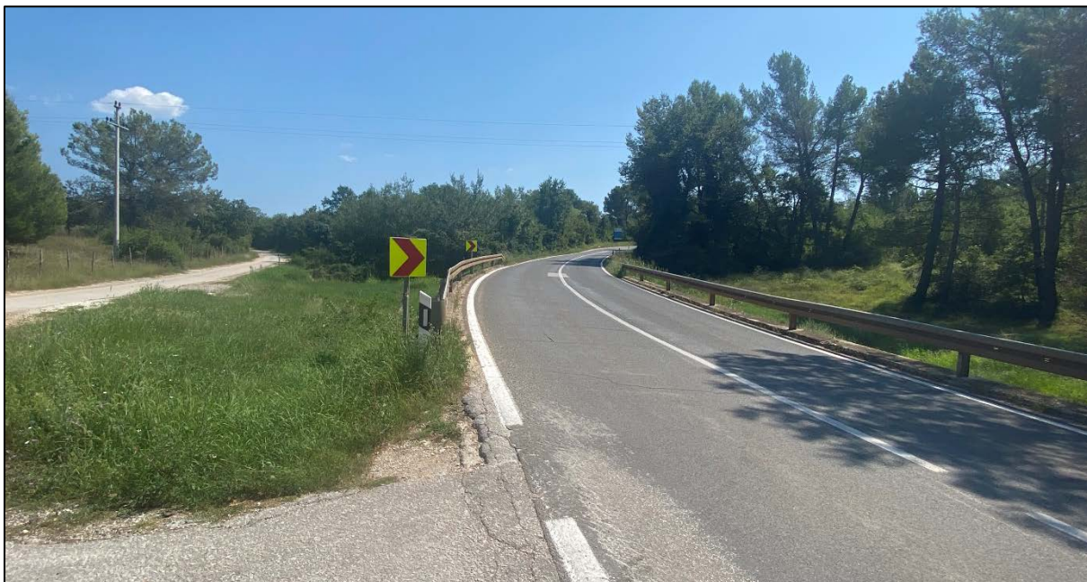
Slika 38. Lokacija na kojoj je predviđeno spajanje dvije nerazvrstane ceste (pogled prema jugoistoku)
