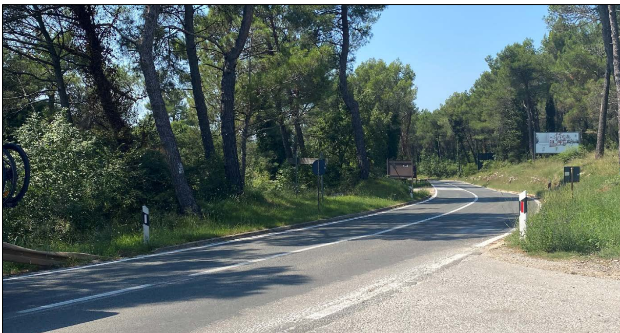
Slika 39. Državna cesta DC75 (pogled prema sjeverozapadu)
