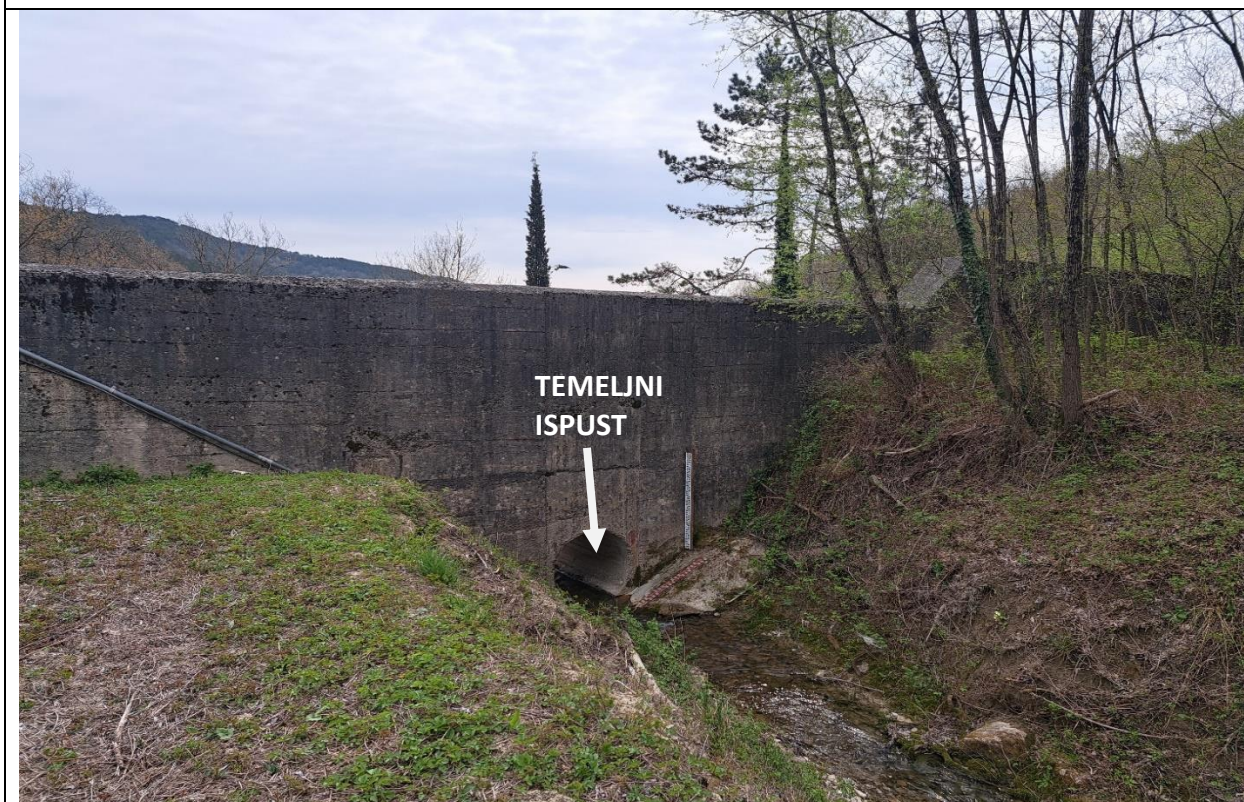
Prikaz betonskog dijela brane sa strane retencije
