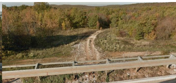
d. Podvožnjak sjeverno prema zapadu_Bale
