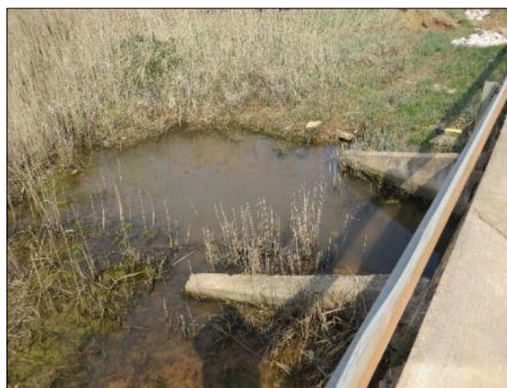
B) Ispust slatke vode bujičnog vodotoka Bujica Brtonigla
