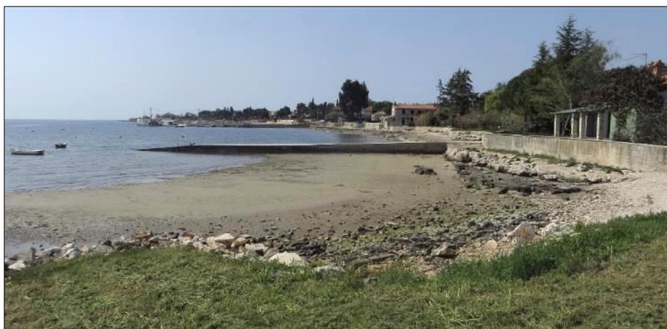
D) Pogled prema zapadu (zahvatu) gdje je dio muljevitih pijesaka ranije zatrpan
