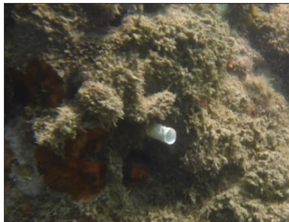
F) Mnogočetinaš Spirorbis sp. na podmorskom dijelu postojećeg lukobrana
