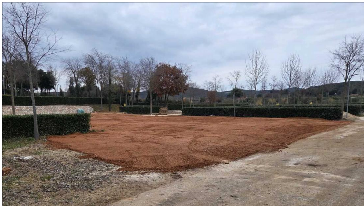
Slika 6. Prikaz stanja na površini za izgradnju sanitarnog čvora nakon vraćanja u prvobitno stanje
