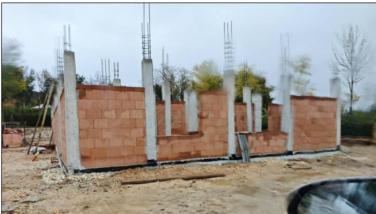
Slika 4. Prikaz započete gradnje sanitarnog čvora
