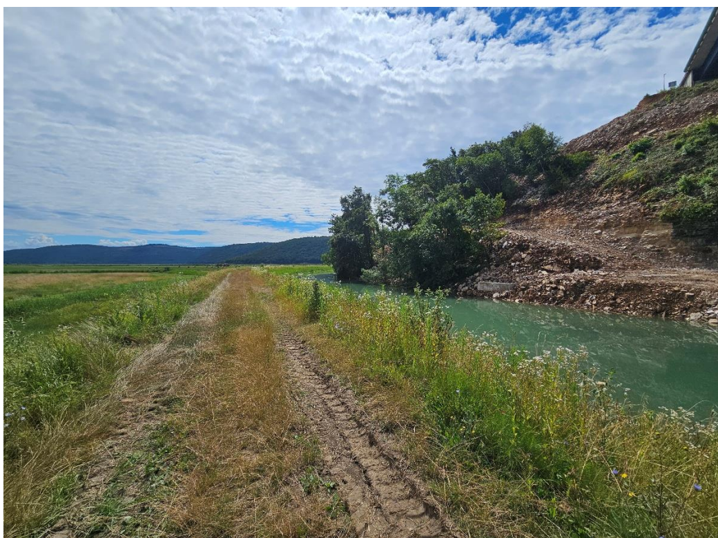
Slika 1.5 Uzvodna dionica obuhvatnog kanala OK3
