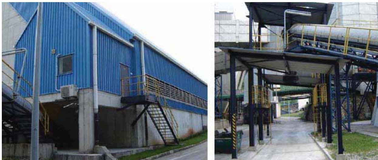
Slika 1.4.5-1: Spremište gipsa TEP 2 (lijevo) i utovarna rampa za gips (desno)
