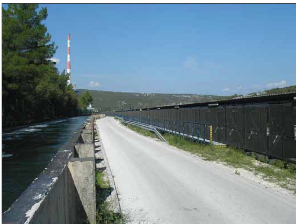
Slika 1.4.1-4: Otvoreni dovodni kanal
