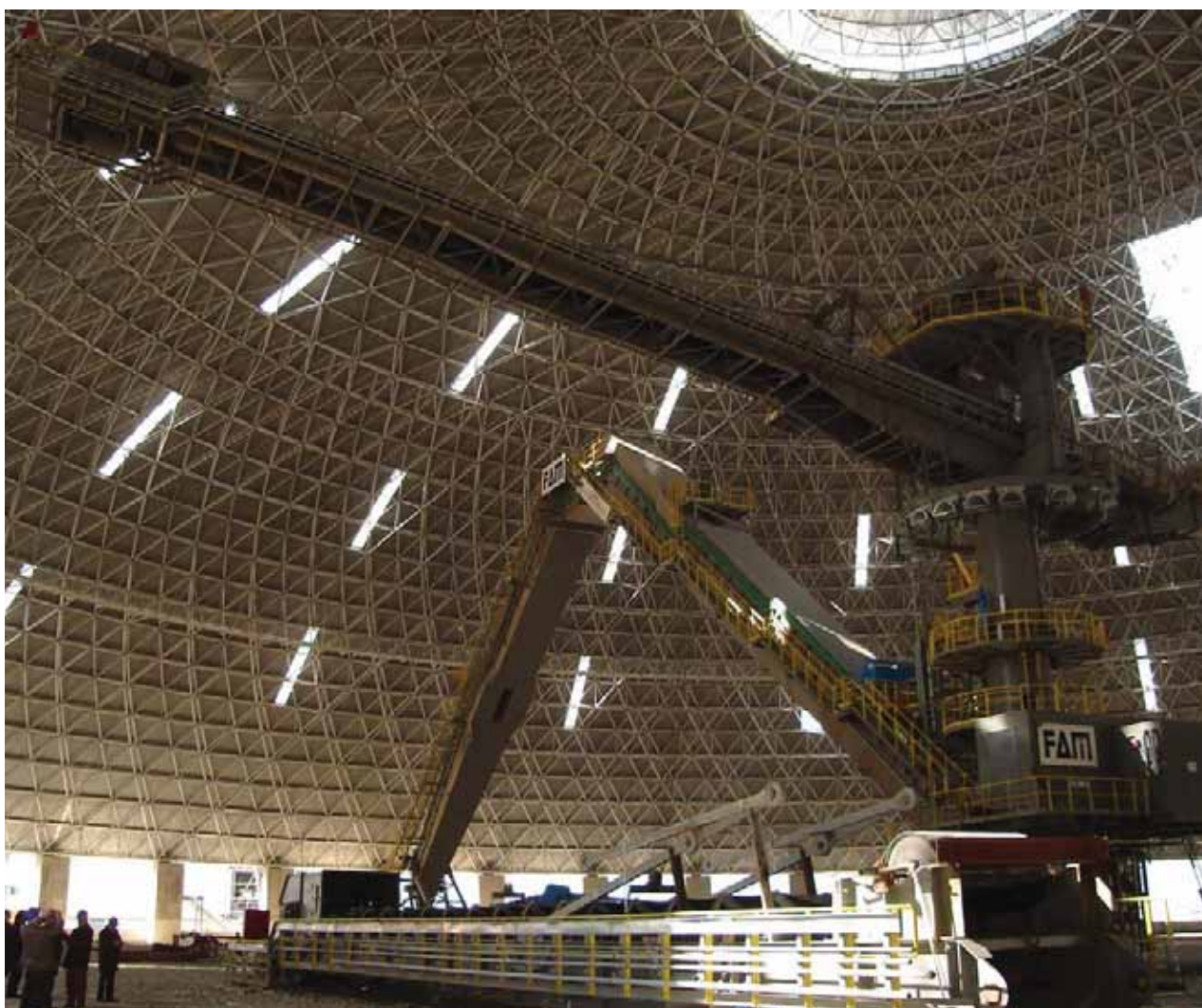
Slika 1.2.2-4: Jedan od dva kupolasta spremnika ugljena u izgradnji, termoelektrana Torrevaldaliga Nord 3 · 660 MW (Civitavecchia, Italija) /Ekonerg 2008./
