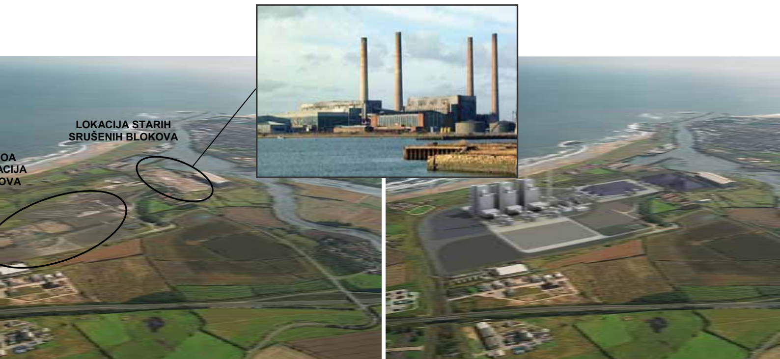
4.6-8: Još jedan projekt RWE npower – nova 3 bloka (3 x 800 MW) termoelektrane na ugljen na lokaciji postojećih blokova A i B (1250 MW) koji su srušeni krajem 2003. godine. U planu je izgradnja «capture ready» elektrane. Projekt je trenutno u fazi studija ( http://www.journallive.co.uk/north-east-news/todays-news/2009/11/10/blyth-power-station-plans-put-on-back-burner-61634-2 )
