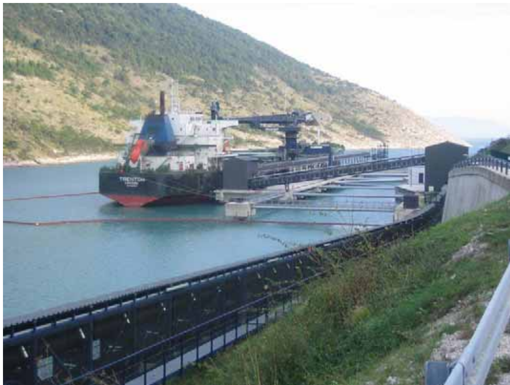
Slika 1.4.2-2: Postojeći iskrcaj ugljena na pristanu u Plominskom zaljevu
