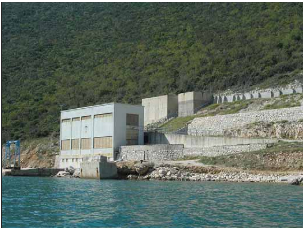
Slika 1.4.1-3: Usisna građevina s pet pumpi
