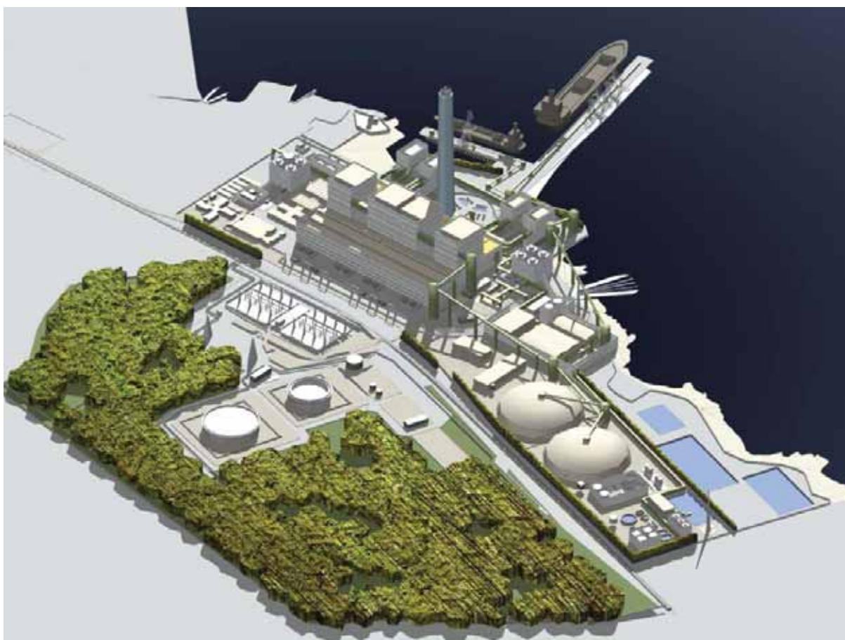
Slika 1.2.2-3.: Trodimenzionalni model termoelektrane Torrevaldaliga Nord, 4 \cdot 660 MW (Civitavecchia, Italija). Dva kupolasta spremnika ugljena, četiri dimovodne cijevi u zajedničkoj armirano-betonskoj oblozi, pristan za dopremu ugljena i manji pristan za otpremu nusproizvoda.
