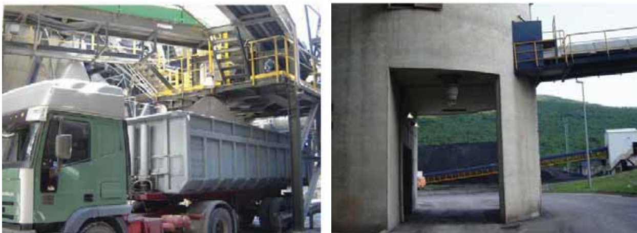
Slika 1.4.5-2: Utovar šljake s gumenog transportera nakon odšljakivača TEP 2 (lijevo) i rampa za utovar ispod silosa pepela TEP 2 (desno)
