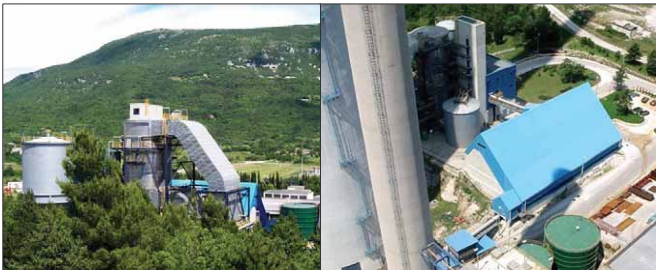
Slika. 1.4.4-2: Postojeće postrojenje za odsumporavanje i skladište gipsa u TE Plomin
