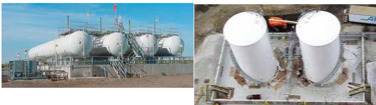
Slika 2.8-1: Spremnici za skladištenje amonijaka, W. A. Parish station, Texas, U.S.A. (lijevo) i vodene otopine amonijaka (desno) 3
