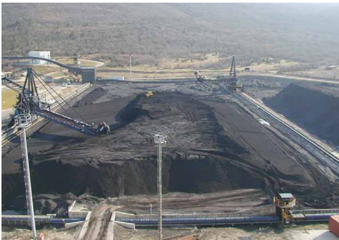
Sl. 1.4.2-5: Pogled na odlagalište/skladište ugljena s kotla TE Plomin 2; u prvom planu transporter T6; lijevo: kombinirani stroj odlagač/uzimač kapaciteta 1 200 t/h / 500 t/h uzima ugljen s većeg polja odlagališta; u pozadini desno: stari odlagač/uzimač kapaciteta 350 t/h / 350 t/h i manje polje odlagališta; u pozadini lijevo: presipni toranj PT3 s cijevnim transporterom
