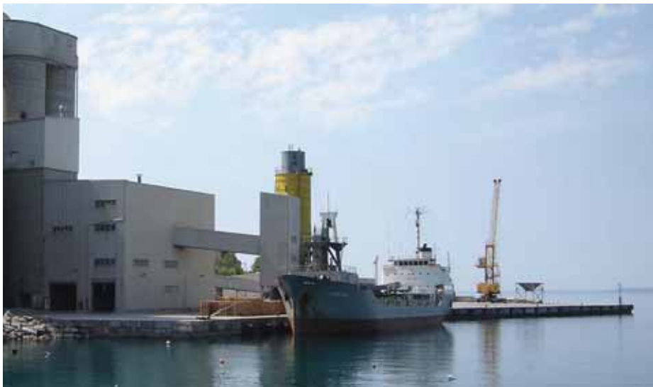
Slika 1.4.5-11: Industrijska luka cementare Holcim u Koromačnom. Uz uređaj za utovar cementa privezan je brod za rasute terete Adriacem I nosivosti 2 303 dwt
