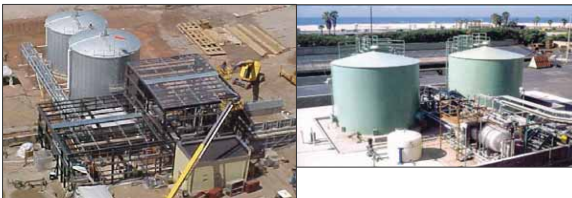
Slika 2.8-2: Sustav dobivanja amonijaka iz uree: AOD TM Mountaineer plant SAD 4 (lijevo) i U 2 A TM5 (desno)
