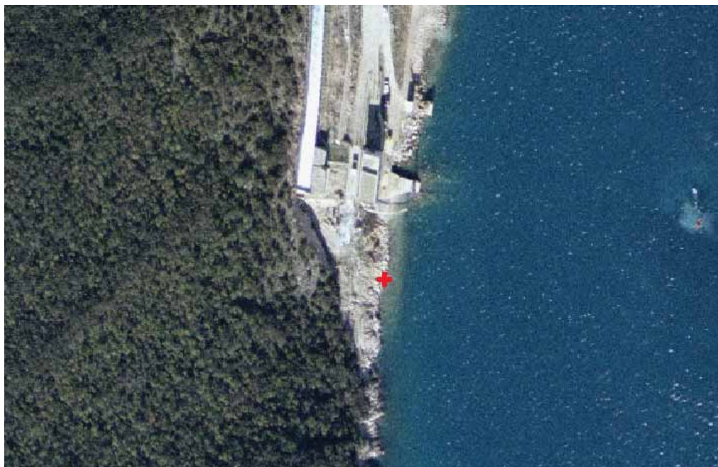
Slika 2.9-6. Lokacija B mogućeg ispusta rashladne vode u blizini sadašnje pumpne stanice
