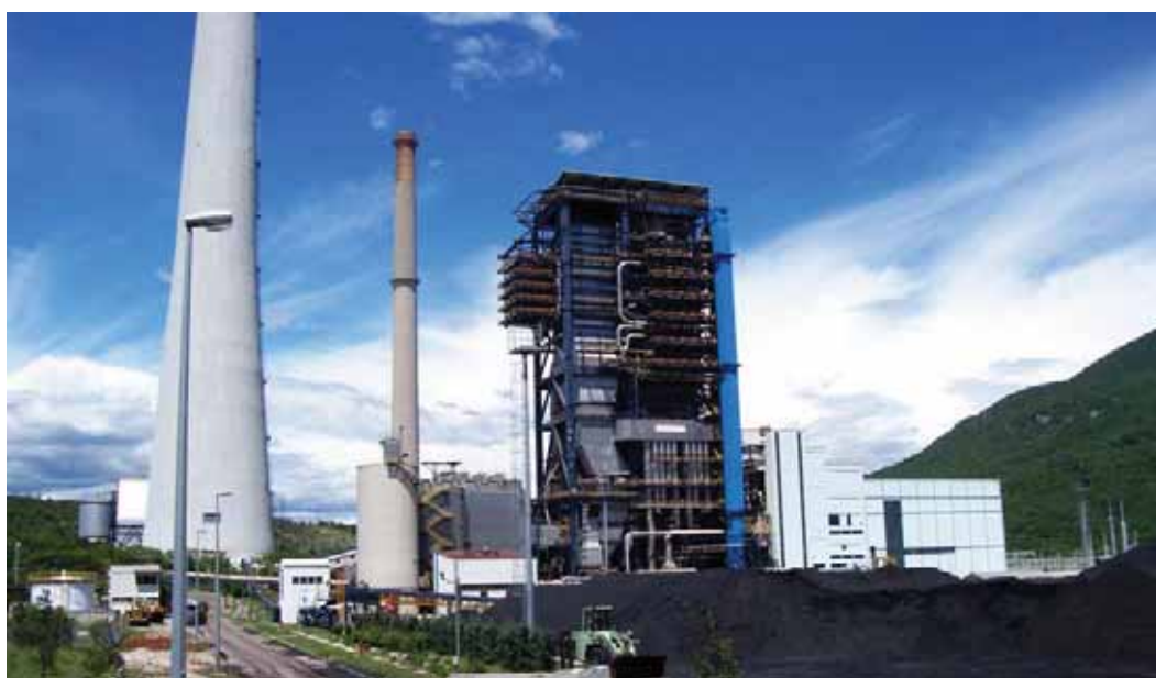
Slika 1.2.1-2: Postrojenje TE Plomin 2
