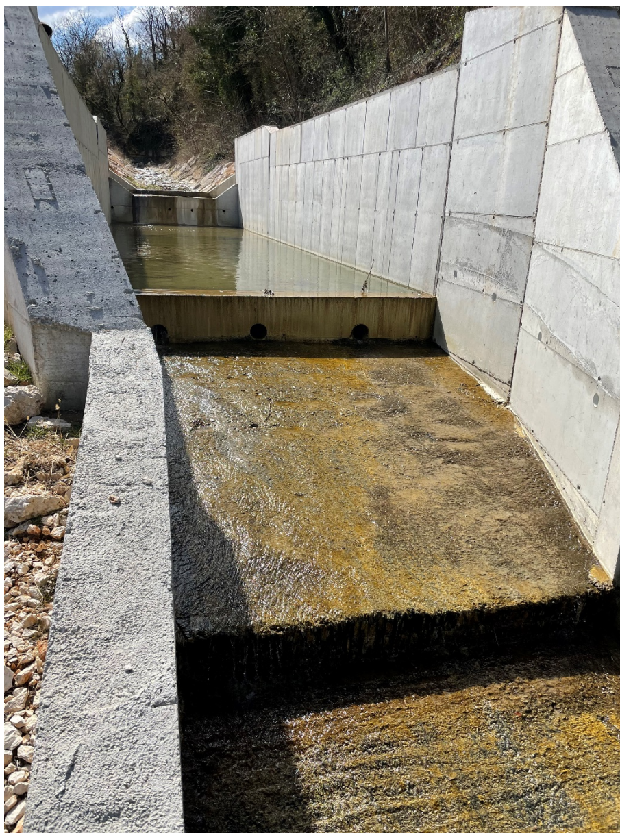
Slika 6. Postojeće stanje – kanal između profila 2 i 7, izvor: Vita projekt d.o.o. (ožujak, 2021.)
