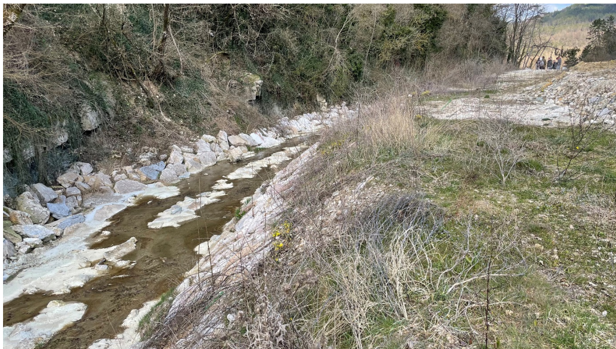
Slika 7. Postojeće stanje – kanal između profila 7 i 16, izvor: Vita projekt d.o.o. (ožujak, 2021.)
