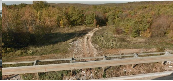
d. Podvožnjak sjeverno prema zapadu_Bale
