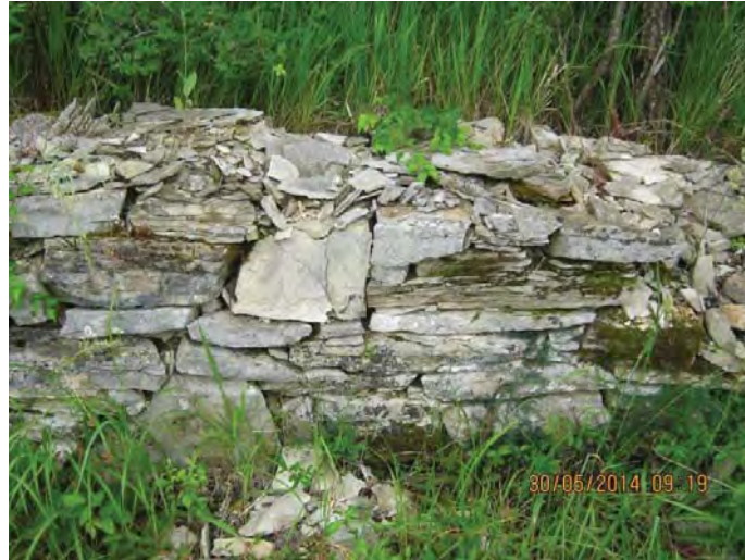
Slika 3.5-4: Tanko uslojeni pločasti vapnenac u suhozidu
