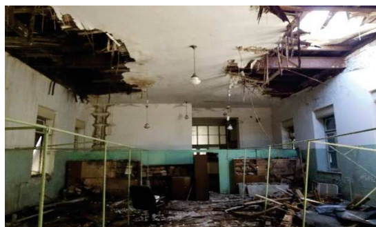
Slika 12: Dvorana prije početka radova
