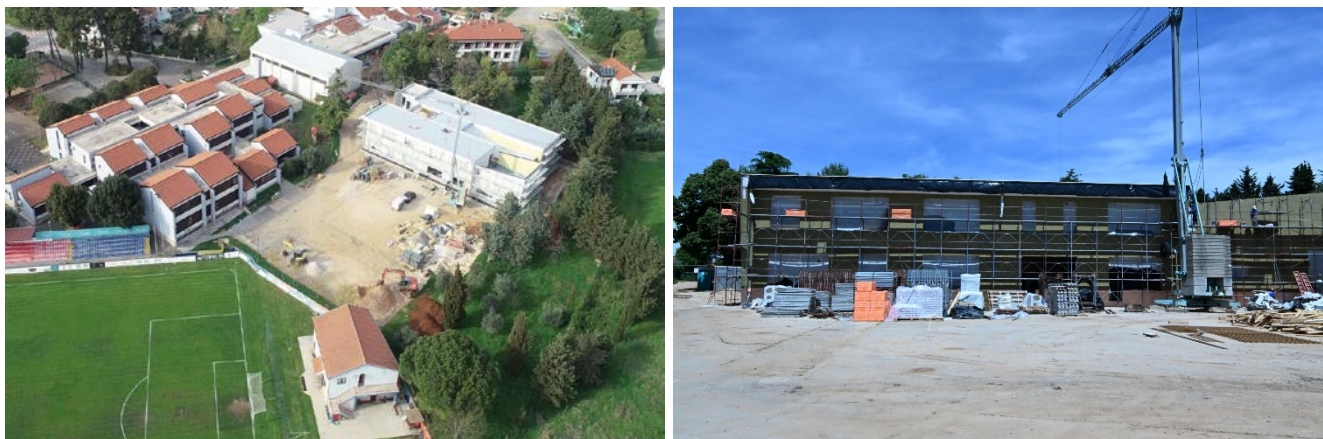
Slika 7: U 2025. godini izvedeni su planirani radovi vezani uz izgradnju nove zgrade Talijanske osnovne škole Novigrad - Scuola Elementare Italiana Cittanova
