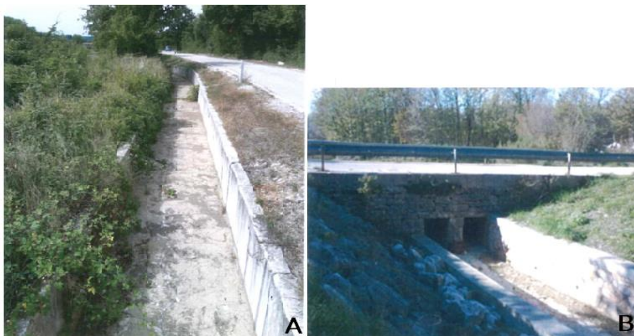
Slika 2.2-8 Betonska kineta uz cestu Labin - Ripenda Verbanci (A); Propust na cesti Labin - Ripenda Verbanci (B) (Izvor: Idejni projekt, travanj 2022)
