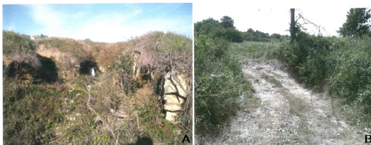
Slika 2.2-5 Oštećene obale korita na poziciji utoka pritoke (A); Prijelaz za poljoprivredne strojeve i vozila kroz korito u središnjem dijelu (B) (Izvor: Idejni projekt, travanj 2022)
