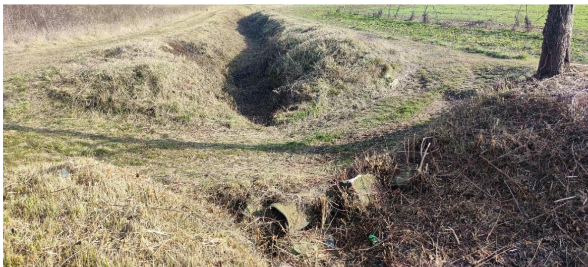
Slika 2.2-3 Postojeći propust na bujici Kature (Izvor: Idejni projekt, travanj 2022)
