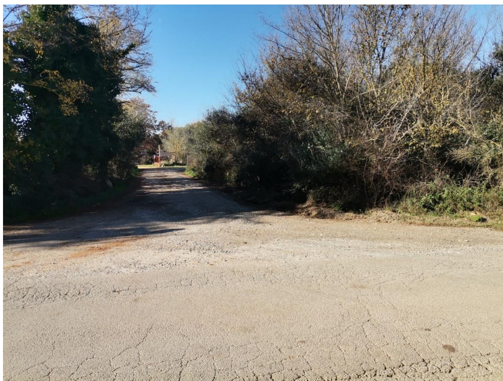
Slika 1.4 Cesta Put od Fortica, buduća lokacija cestovnog propusta
