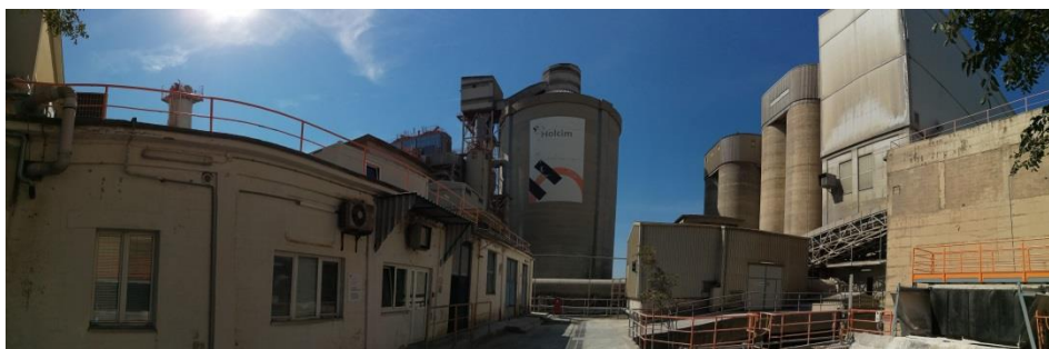
Slika 84. Pogled s ceste na silos klinkera i silose cementa, (T4)
