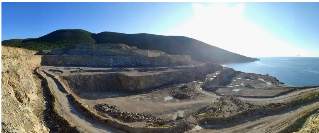
Slika 79. Pogled na eksploatacijsko polje u Koromačnu
