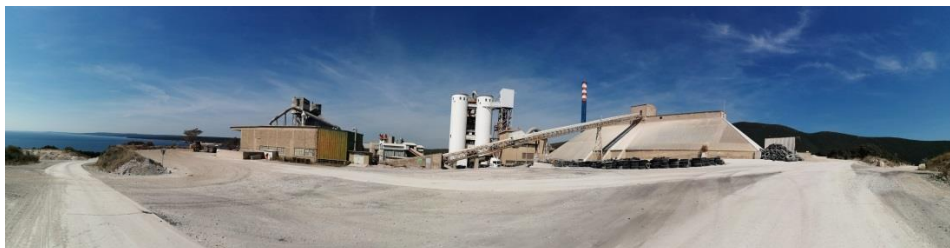
Slika 81. Pogled s ceste na deponiju sirovine, drobilanu, dnevni spremnik otpadnih guma i silose homogenizacije (T1)
