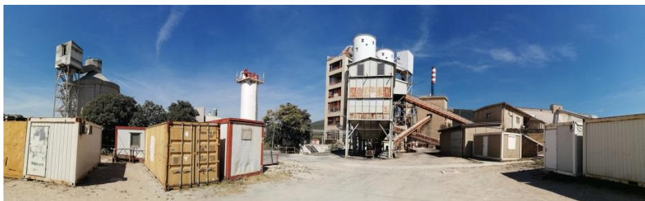
Slika 83. Pogled s ceste na bunker ugljena i koksa, silose homogenizacije i izmjenjivač topline, (T3)
