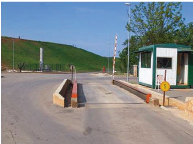
› La discarica Košambra gestita dalla ditta Usluga di Parenzo dopo il recupero di parte della discarica - la bilancia all'ingresso e il sistema di degassamento
