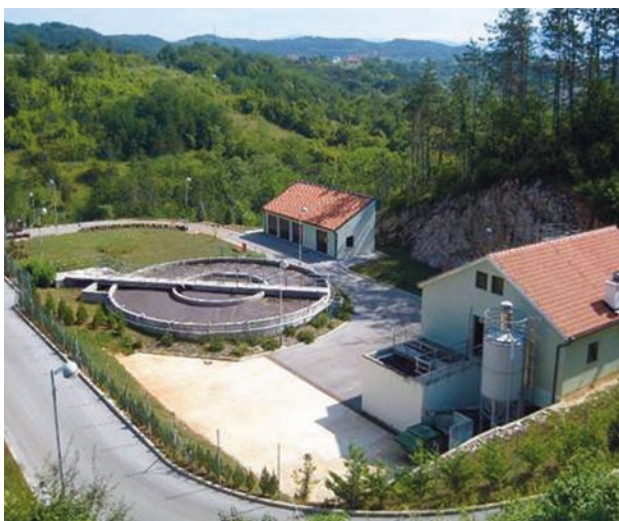
› Uređaj za pročišćavanje otpadnih voda grada Pazina
