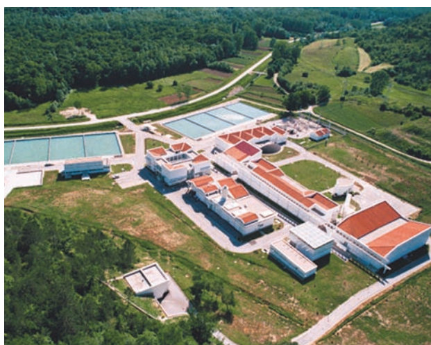
› Istarski vodovod Buzet – postrojenje za obradu voda
