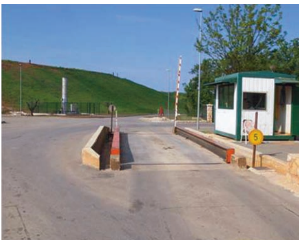
› Odlagalište Košambra kojim upravlja Usluga Poreč nakon provedene sanacije tijela odlagališta - kolna vaga na ulazu i sustav za otplinjavanje
