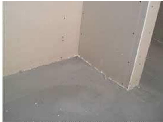
Nakon što estrih dovoljno otvrdne odreže se suvišak PE folije i stiropor trake
