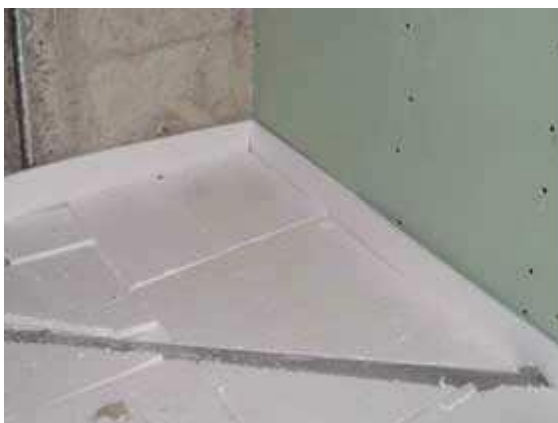
Između instalacija najprije se polože ploče Stiropora EPS 100 ili 150, šupljine i neravnine popune suhim finim pijeskom, a na njih se polože ploče elastificiranog Stiropora T
