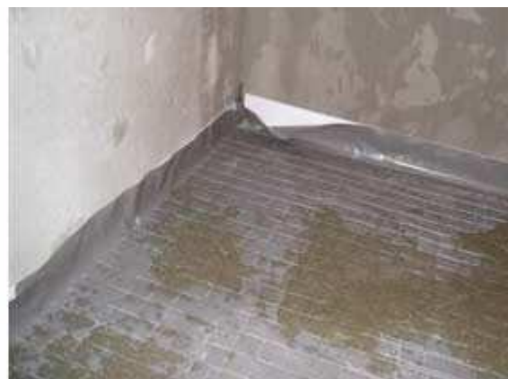
Polietilensku foliju treba podignuti uz vertikalno postavljene trake elastificiranog stiropora najmanje 2 cm više od predviđene visine estriha
