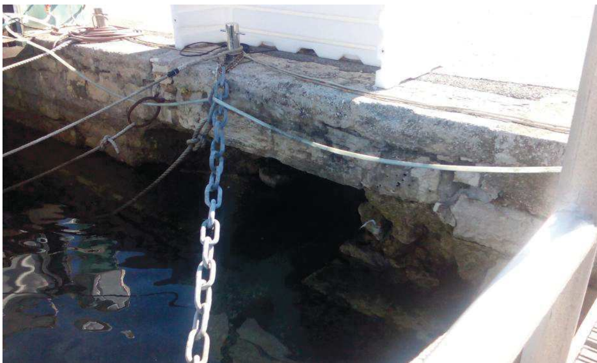
Slika 15.4. – postojeći utok kanala na obalnom šetalištu (otvor u rivi)
