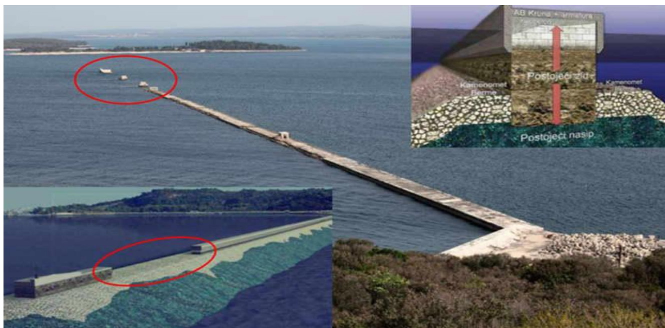
Slika 2: Prikaz lokacije i tehničkih obilježja projekta Rekonstrukcija lukobrana u luci Pula – PULA BREAKWATER
