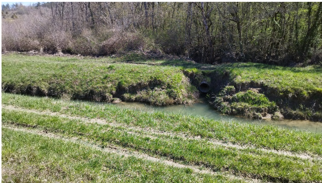
Slika 13. Postojeće stanje na lokaciji planiranog sifonskog prijelaza
