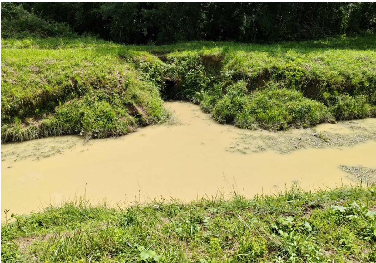
Slika 7. Postojeće stanje na lokaciji planiranog sifonskog prijelaza ispod oteretnog kanala i prometnice (pogled na postojeći spoj bujice Butoniga i oteretnog kanala)
