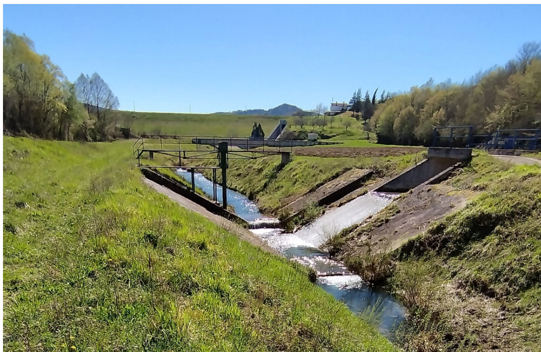
Slika 11. Postojeće stanje na lokaciji planirane preljevne građevine i sifonskog prijelaza
