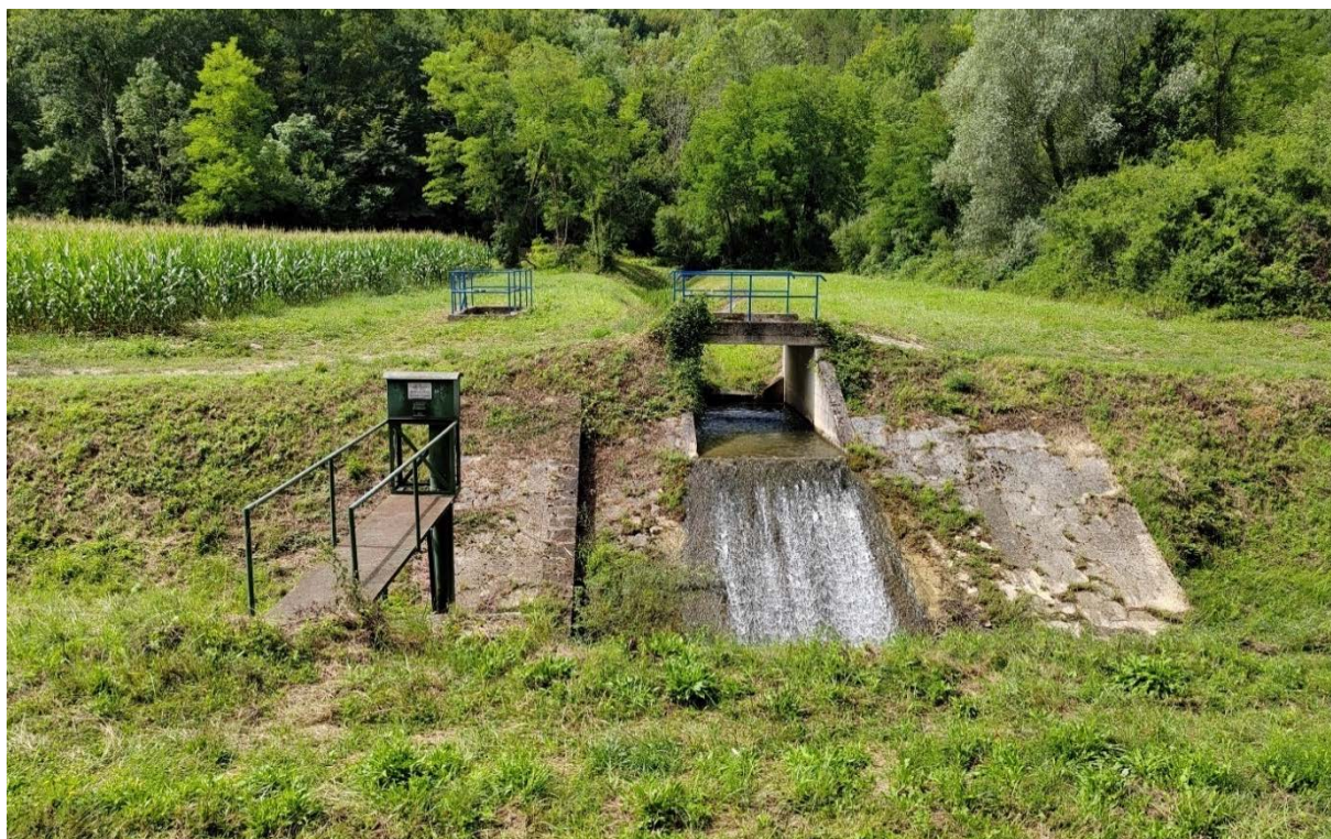
Slika 4. Postojeće stanje na lokaciji preljevne građevine na oteretnom kanalu Butoniga (pogled na lijevu pritoku oteretnog kanala)
