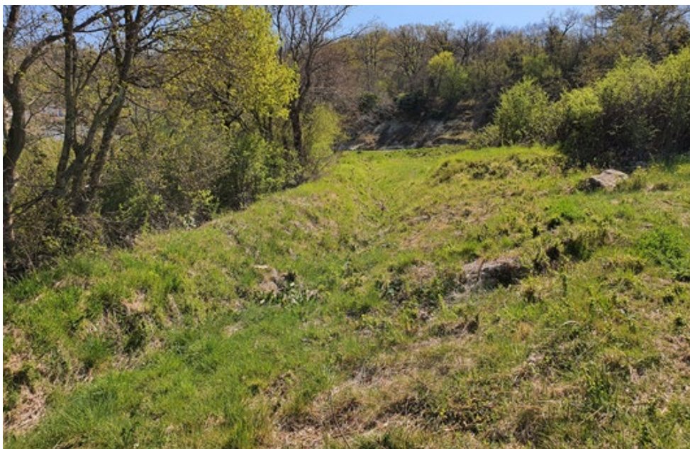
Slika 2.3.-13. Postojeće korito nizvodno od propusta na lokalnoj cesti
