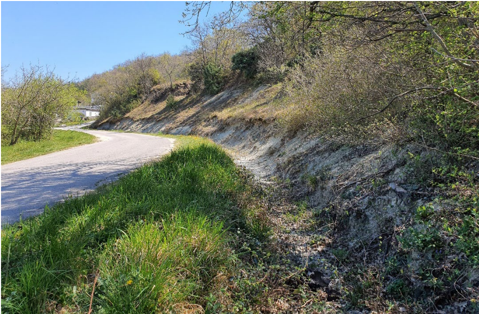
Slika 2.3.-6. Nagli pad terena prije križanja s lokalnom cestom i cijevnim propustom
