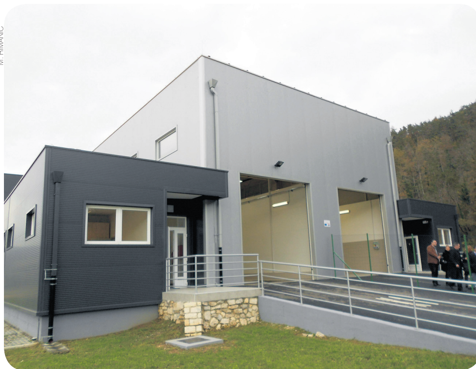
Zgrada novog sabirališta
