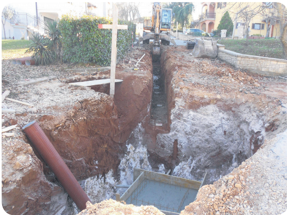
Gradilište kanalizacije u Stanciji Pataj
