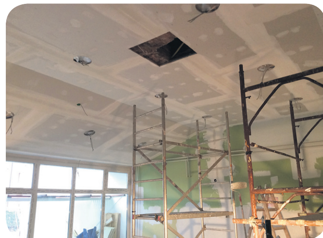
Energetska obnova zgrade vrtića "Tičići"
