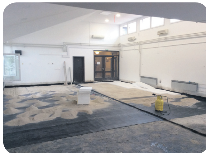
Radovi u vrtiću "Tičići"
