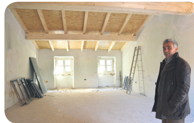
Posljednja od tri etaže zgrade koja se rekonstruirala uz nadzor konzervatora - Anton Pletikos
