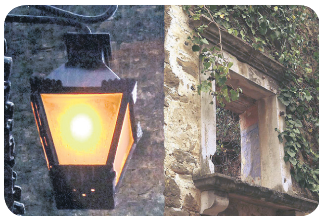
Završje vapi za obnovom
