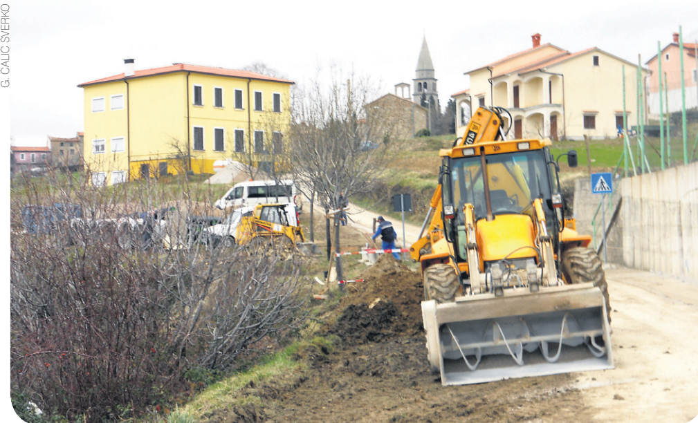
U tijeku izgradnja pročištača Vrh
