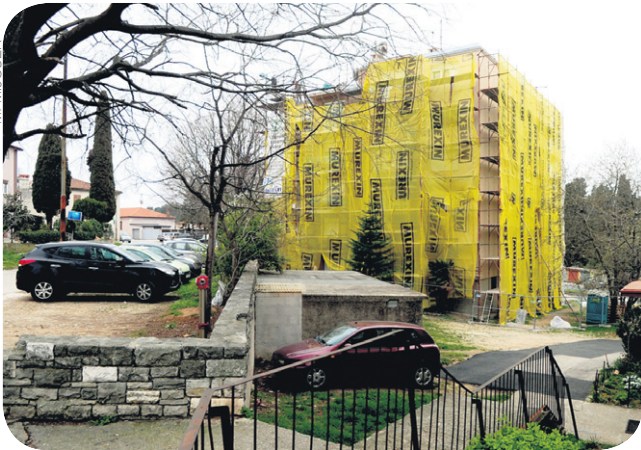
Energetska obnova zgrade u Uskočkoj u Puli
