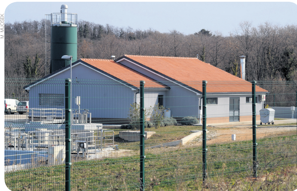
Izgradnja sustava za pročišćavanje otpadnih voda
