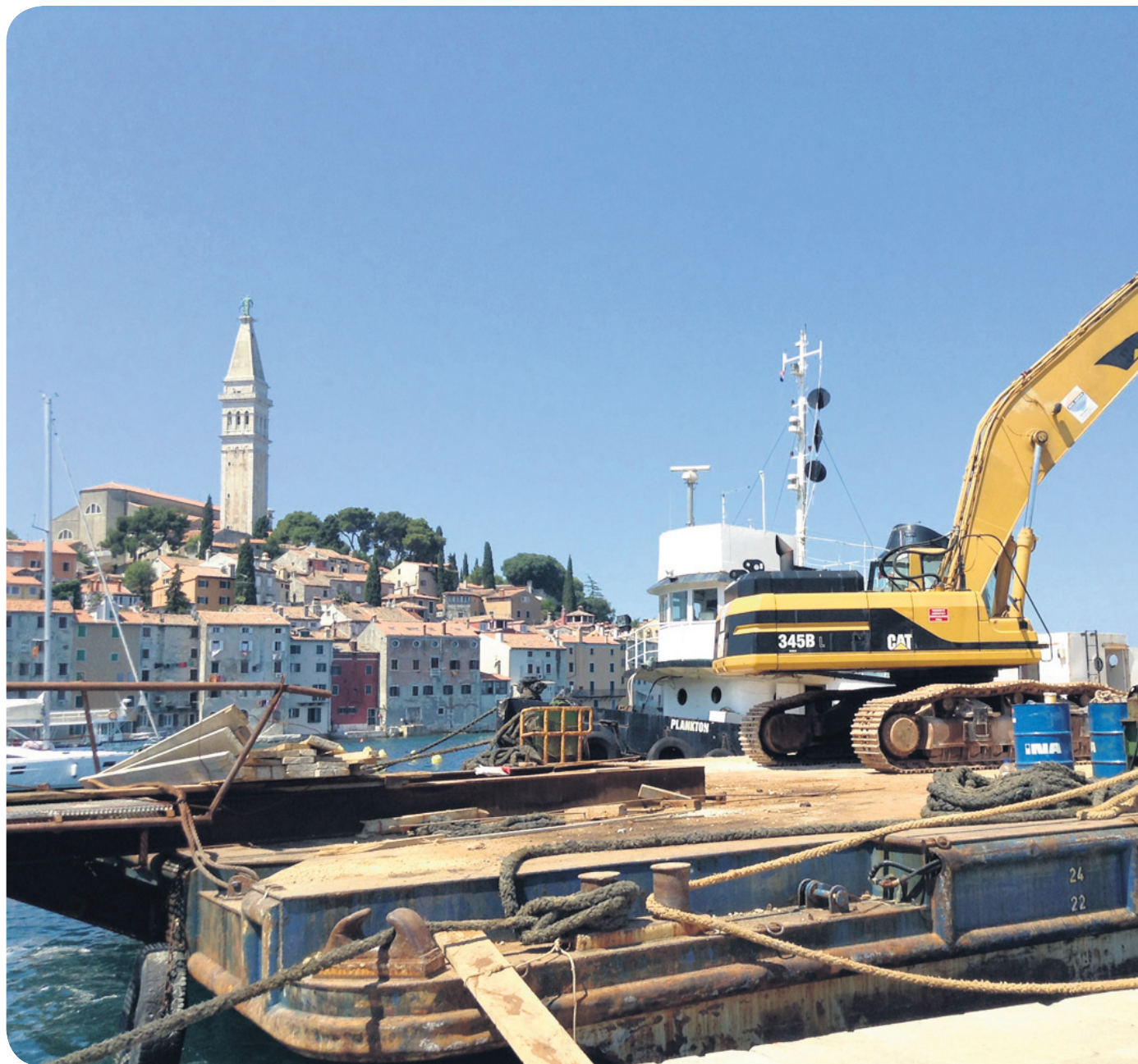
Obnova dijela lučke infrastrukture u Rovinju
