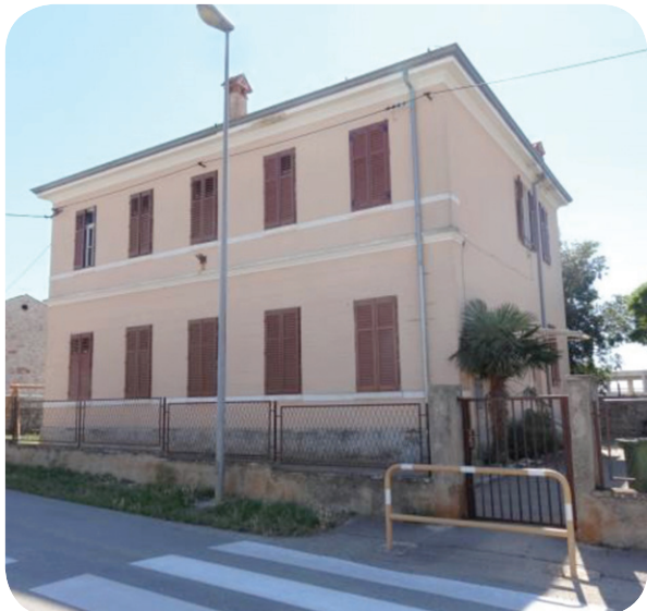
Zgrada škole u Velom Maju prije...
