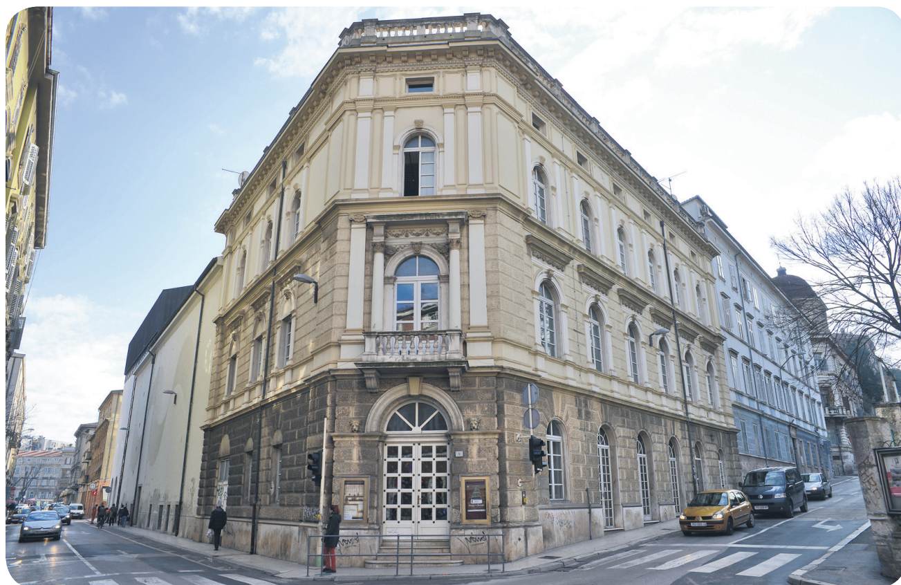
Razmatra se mogućnost energetske obnove zgrade INK-a
