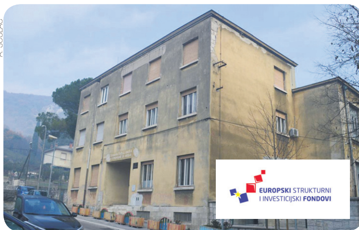
Potrebna toplinska energija za grijanje smanjit će se za 64 posto
