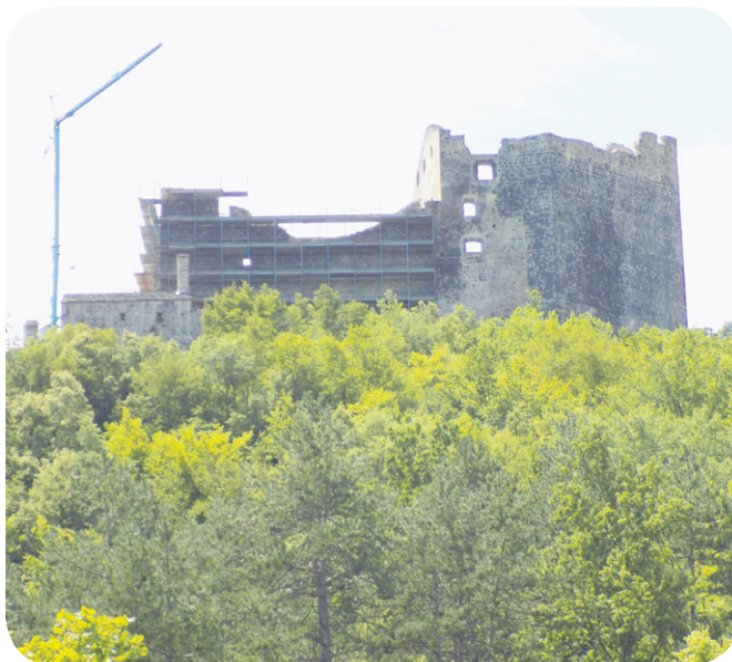
Sanacija postojećih zidina središnjeg dijela korpusa kaštela
