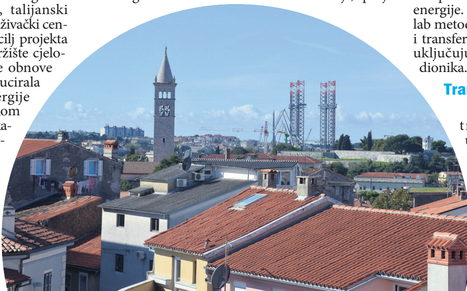
HAPPEN promovira cjelovitu energetska obnovu zgrada na području Mediterana
